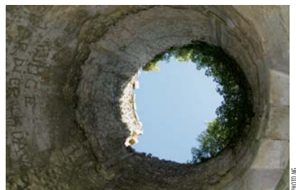
Poste de Blanzac, l'intérieur de la tour.
